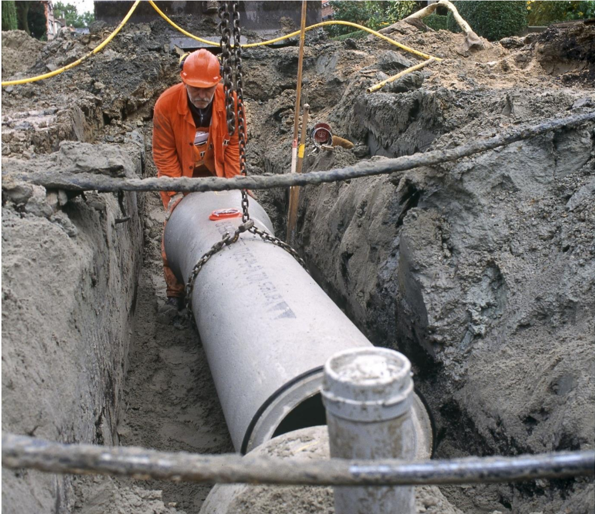
Aanpassing aan riolering: Schoon regenwater wordt niet meer afgevoerd via het riool.
